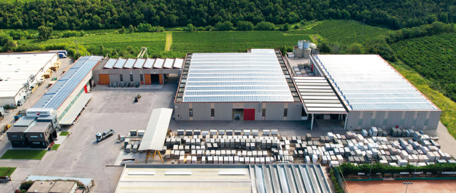
Das Werksgelände von Marmi Rossi aus der Luft. Ein Großteil der Hallendächer dient der Stromproduktion durch Photovoltaik-Anlagen. Eine Erweiterung der Solaranlage ist geplant. Fotos: Marmi Rossi
